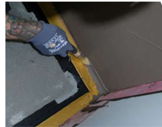
Eckbereiche einpinseln und 2K eindrücken.
