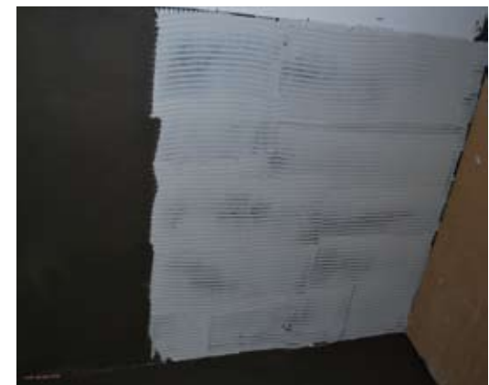
Fliesenkleber an Wandflächen aufziehen
