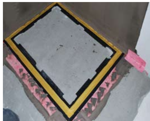
Eckbereiche nochmal zusätzlich überkleben
