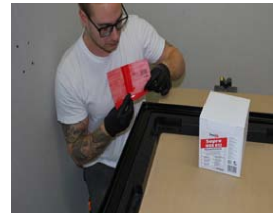
Formteile zuerst ankleben!
