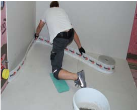
Randdämmstreifen ausrollen & positionieren.
