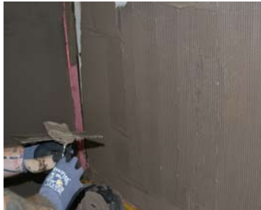
2. Seitenwand einziehen
