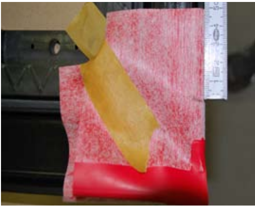
Mind. 5 cm für die Überlappung anzeichnen!
