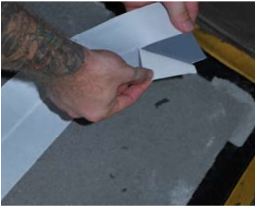
Strecke messen und Dichtband abziehen.
