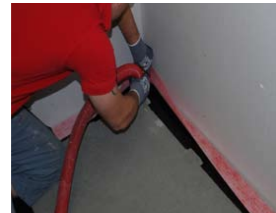
Klebeband abziehen und Flächen absaugen.
