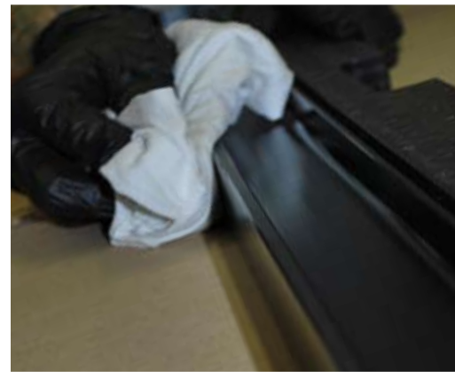
Auch die Oberkante sorgfältig reinigen.
