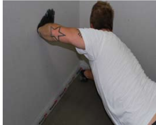
Randdämmstreifen abschneiden
