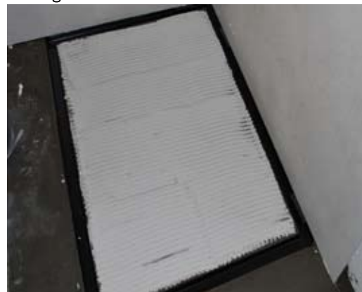
Mittelflächen mit Kleber aufziehen
