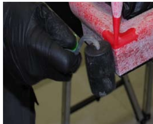
Mit einer Rolle zusätzlich nachdrücken!
