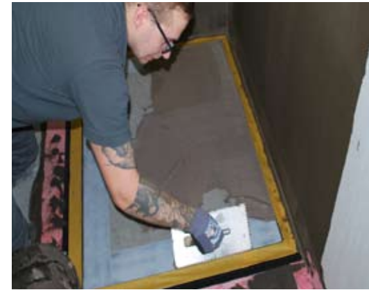
Nut füllen und bis in die Ecken aufziehen.
