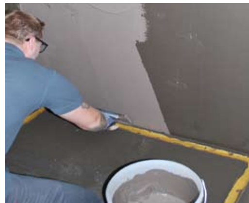
Abdichtungsvorgang: 1-2 Mal wiederholen
