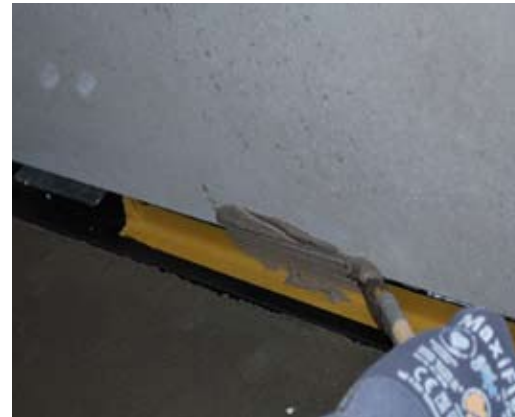
Fuge zwischen Fliese und System mit 2K ausfügen.
