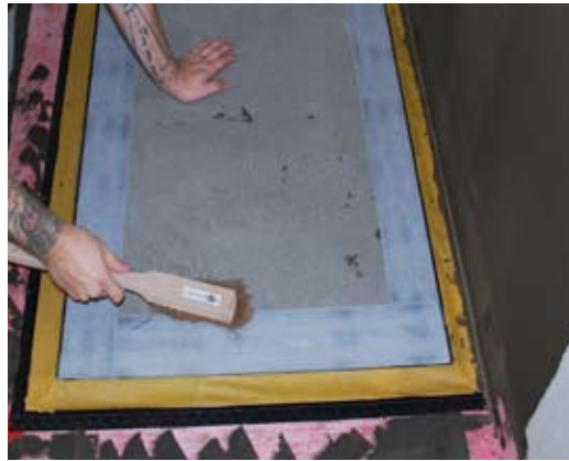
Schutzklebeband aufziehen und abfegen.
