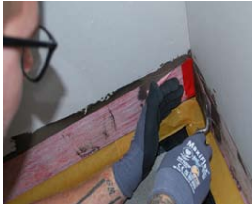
Dichtbänder und Formteile fest andrücken!
