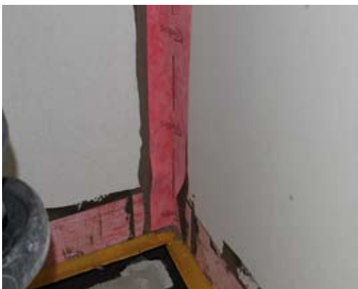
Dichtband messen und einbringen
