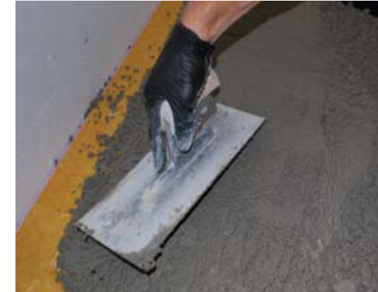
Im Mittelbereich den Estrich einbringen.
