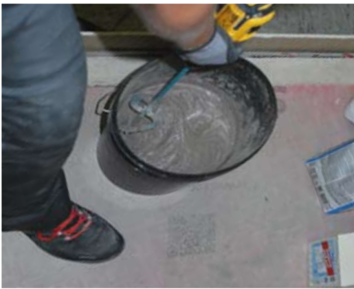
2K Abdichtschlemme anrühren
