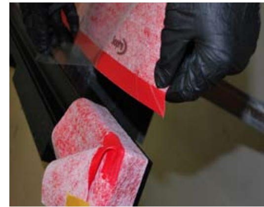
WDB passend schneiden und ankleben!
