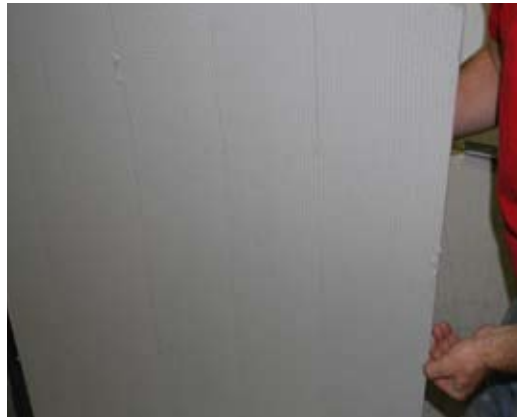
Fliesenrückseite mit Fliesenkleber bestreichen
