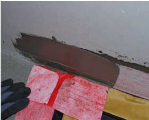
2K satt aufziehen bei den Überlappungen
