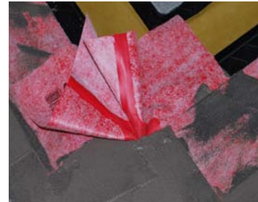
Seitenteile satt unterspachteln
