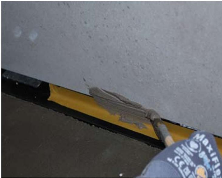
Fuge zwischen Fliese und System mit 2K ausfugen.
