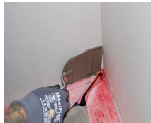
2K Abdichtschlemme aufziehen
