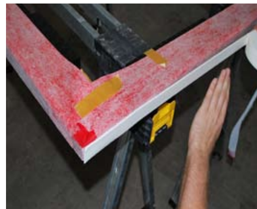
Schallschutzband an den wandliegenden Seiten ankleben.
