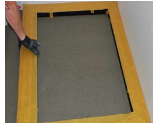
Duschsystem positionieren
