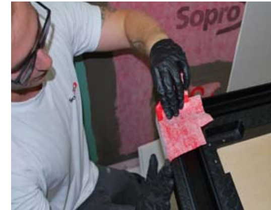
Präzise und in passender Höhe ankleben.
