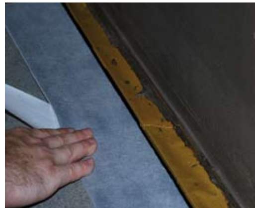
Bis zur Feder ansetzen und in die Nut kleben!
