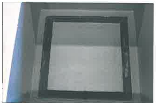
Bild 2: komplett abgedichtetes Becken
