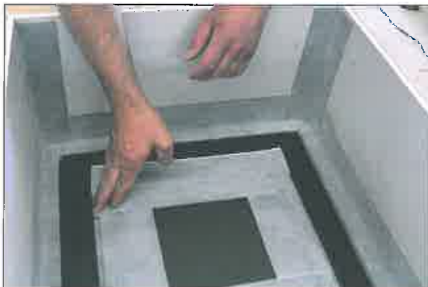
Bild 1: Becken nach Einbau der Dichtbänder
