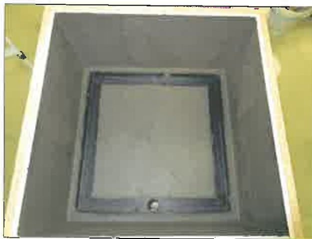
Bild 2: komplett abgedichtetes Becken
