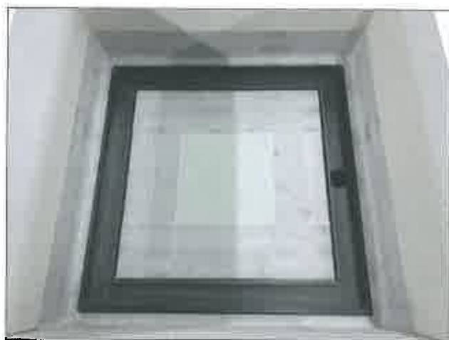
Bild 1: Becken nach Einbau der Dichtbänder
